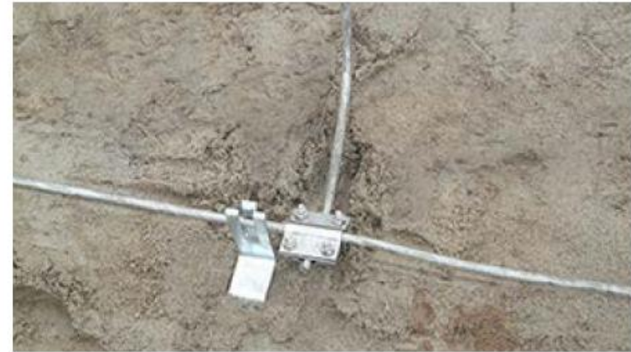
Abbildung 18 Detailaufnahme Verbindung Erdreich
