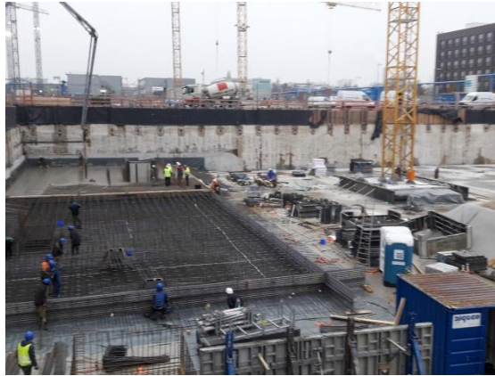
Abbildung 2 Bodenplatte
