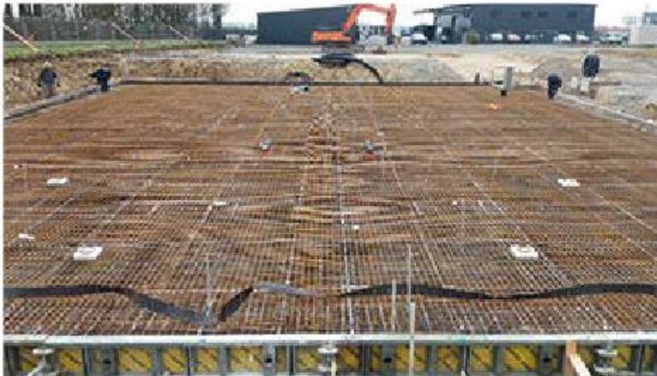
Abbildung 13 Erdungsanlage – unterschiedliche Blickwinkel
