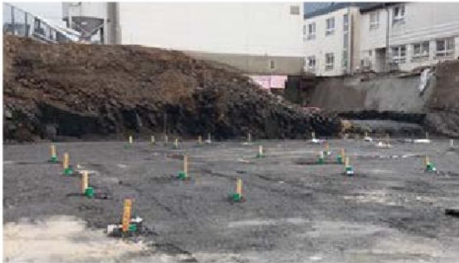
Abbildung 11 Bildhintergrund – Bsp. Ringerder
