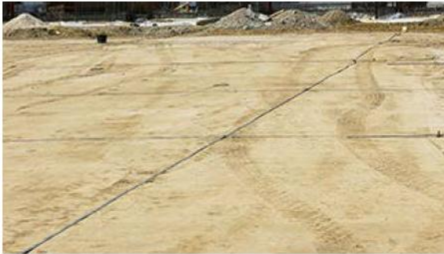
Abbildung 17 Verbindungen Erdreich
