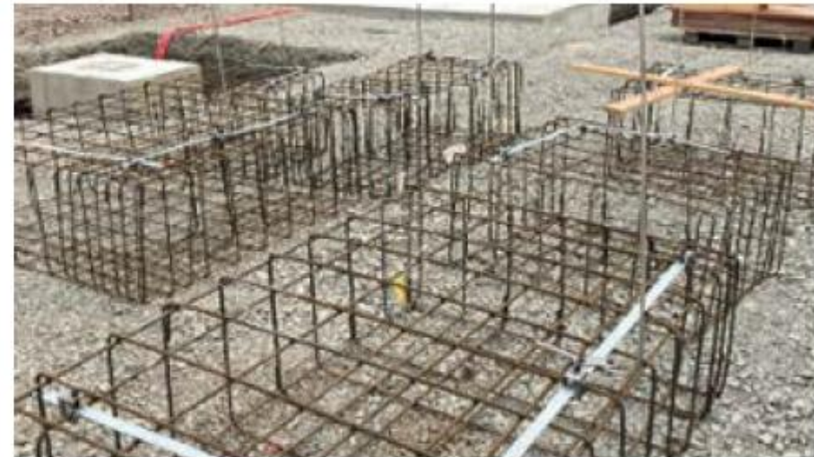
Abbildung 16 Detailaufnahme Anschlusspunkte Einzelfundament
